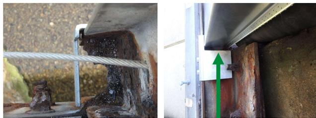
ツタイキャッチャーにより、新設遮音板を設置する事が可能
