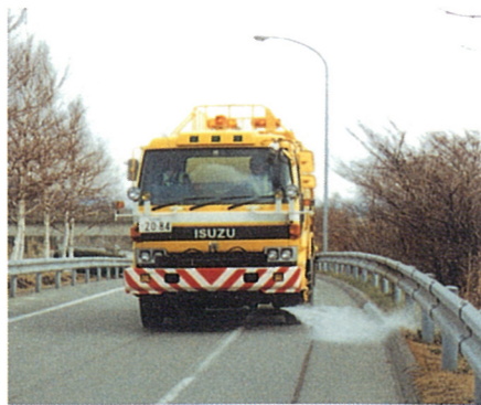
路面清掃作業
