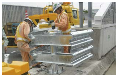
ガードレール補修
