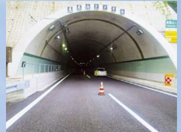
圏央道 高尾山トンネル はく落対策工事
