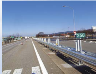
北陸道 富山防護柵工事
