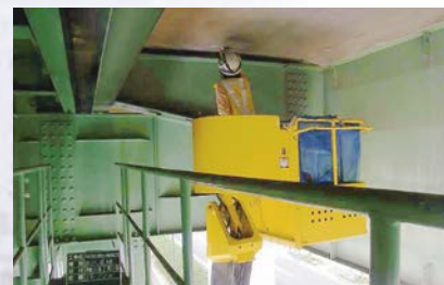
コンクリート床版の点検
