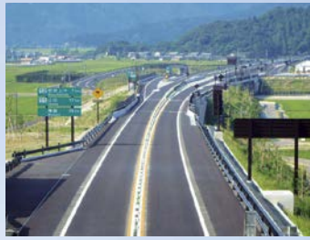
舞鶴若狭道(若狭国定公園内) ガードレール、ボックスビーム、落下物防止柵 飛雪防止柵、他工事
