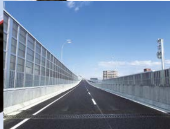
県道高速名古屋新宝線 七番工区遮音壁設置工事
