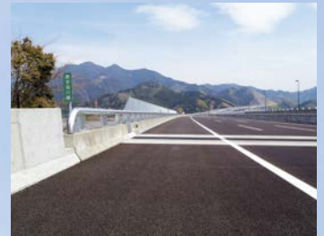
新東名 静岡東 鋼製高欄、落下物防止柵工事
