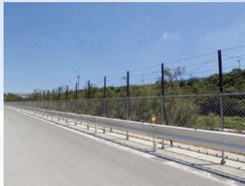
新東名 浜北 立入防止柵(嵩上げ)工事
